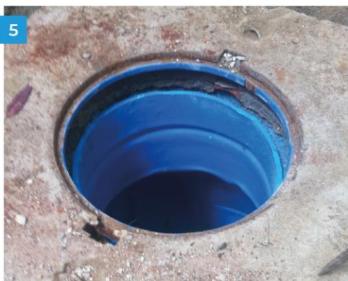
5 Finalização da instalação
