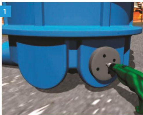
1 Abertura da entrada dos tubos
